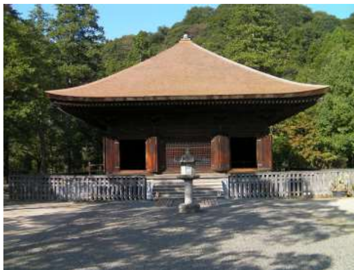
国宝 白水阿弥陀堂(いわき市・金色堂を模したといわれる) 岩城家祖則道の正室 奥州藤原氏初代清衡の娘徳姫 建立
